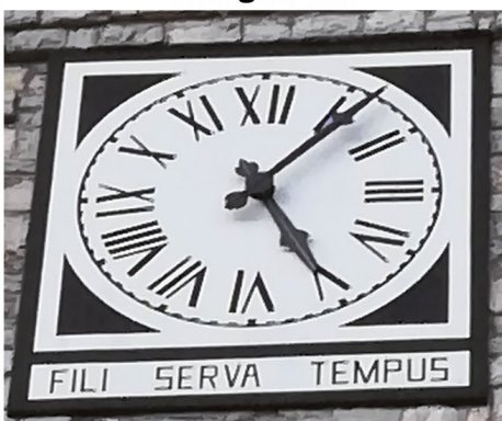
Binago (VA) Restauro orologi da torre - 2018
