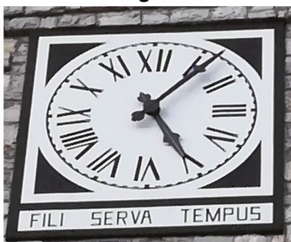
Binago (VA) Restauro orologi da torre - 2018
